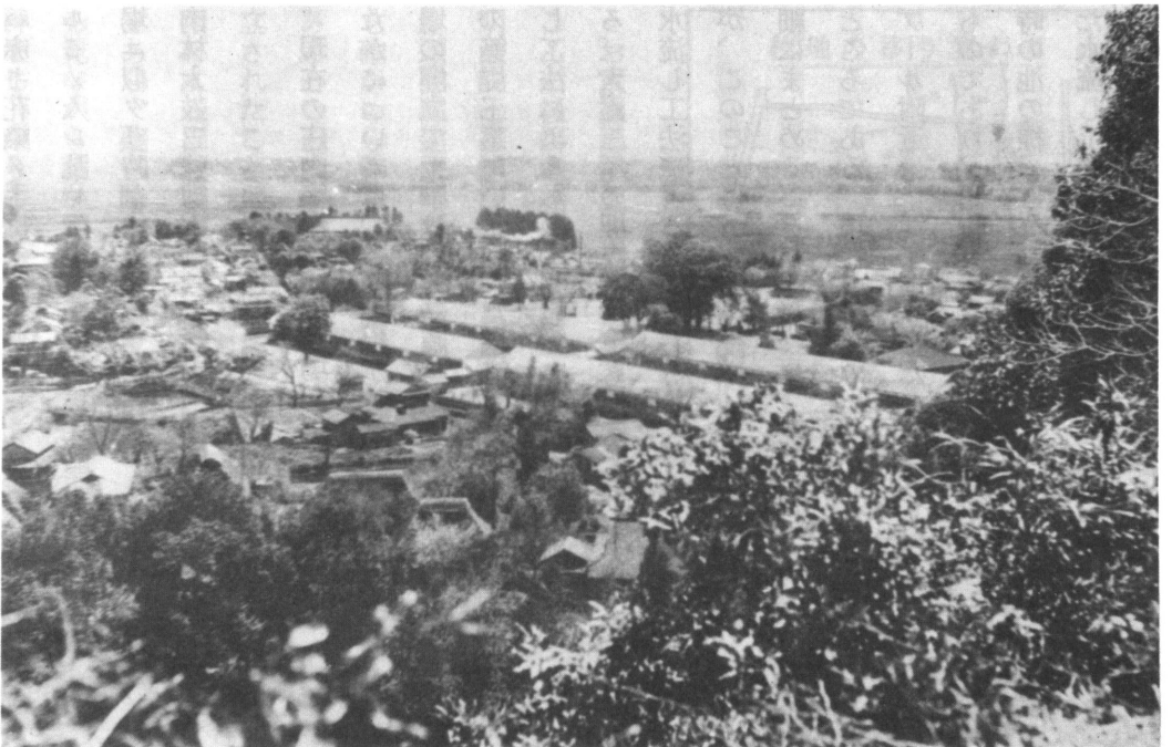
(昭和10年3月28日) 城山の一角から見下した当時の校舎全景
