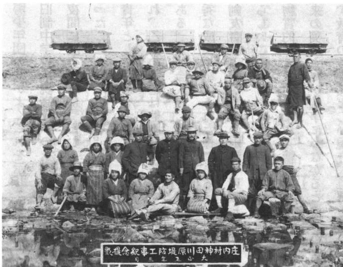
庄内村神田川原堤防工事 記念撮影 大正五年三月 (後方に工事に使われたトロッコが見える)
