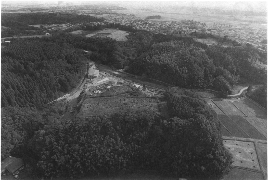
安永城全景 手前金石城の発掘現場
