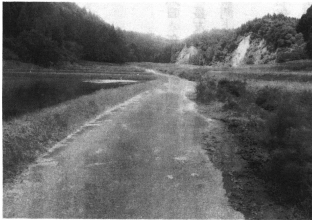
庄内村議회가固執する郷田川線（現況）
