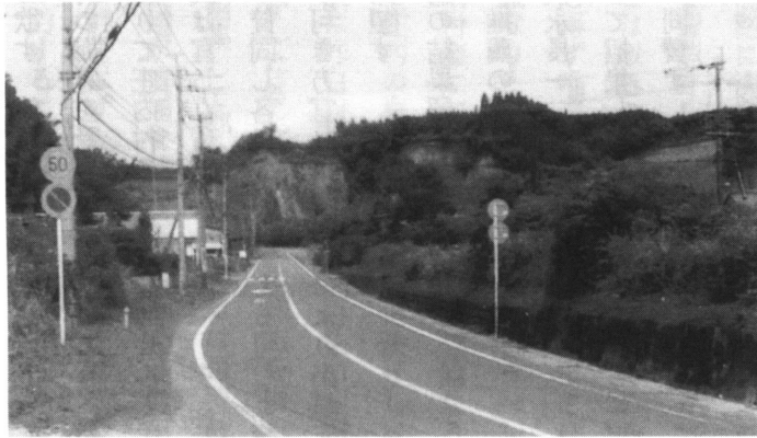
郡役所が強行開設した路線（現況）
