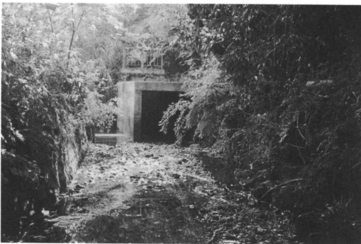
南前用水路取水トンネル口
