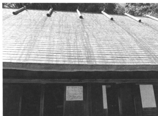
国指定重要文化財那須家住宅（鶴富屋敷）
