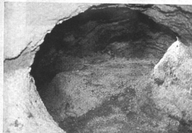
1991(平成3)年 崩落した土砂を取り除いた状態【内部写真】
