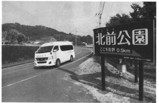
北前公園入口看板設置
