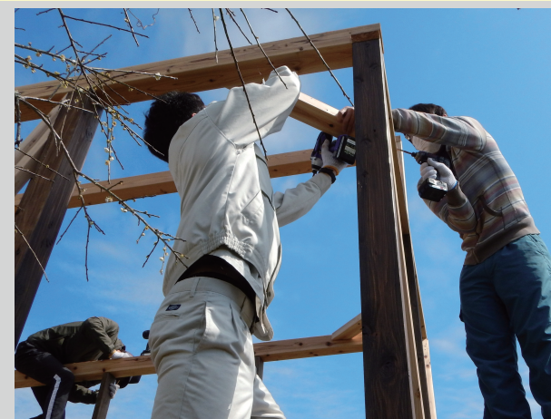
2019年3月15日 梁や火打ち等の補強作業
