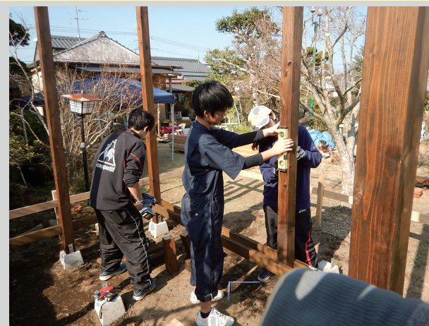
2019年2月26日 柱建て方の作業
