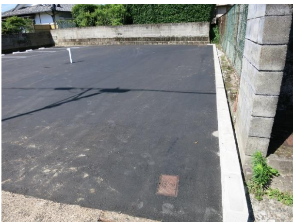
舗装工事写真
