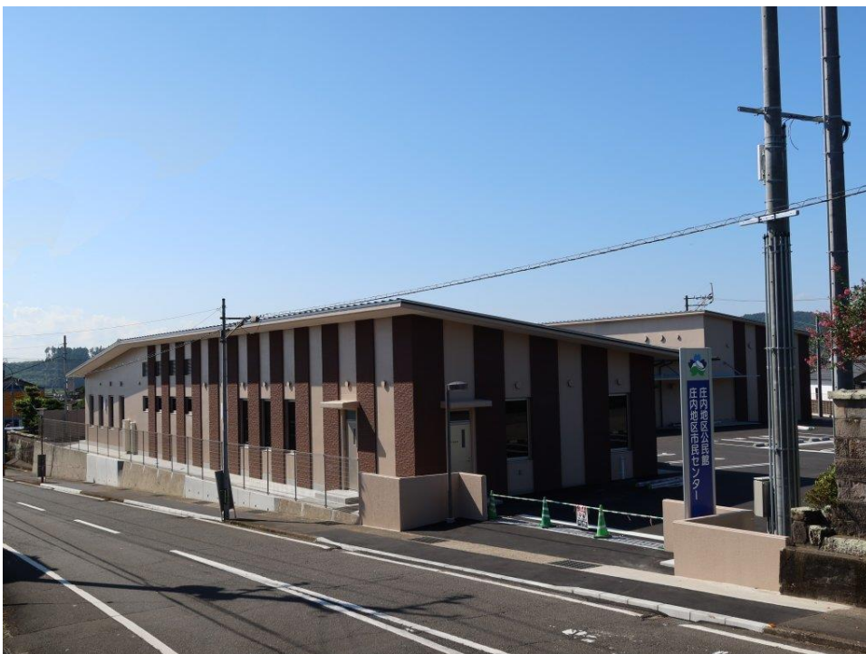
庄内地区公民館及び庄内地区市民センター2020.10.26 供用開始
