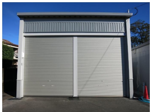
倉庫完成写真
