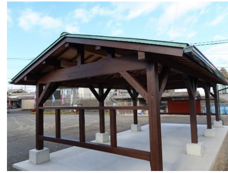
千草自治公民館移築後(令和5年2月)
